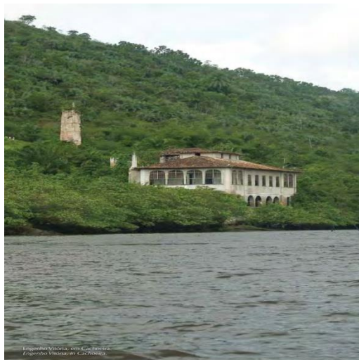
Engenho da Vitória/ Fonte: IPHAN Fonte: IPHAN
